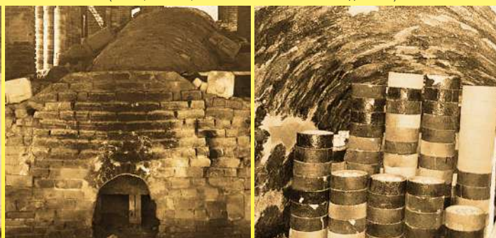
Традиционная китайская печь «Дракон» (龙窑, лун яо), загрузочное отверстие печи и метод закладки электротехнического фарфора (частная коллекция)
